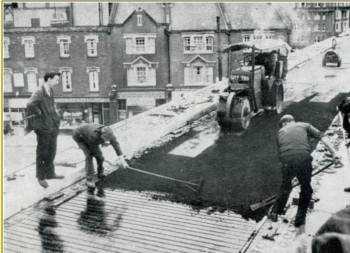
1969 Posa dell'asfalto sulla carreggiata superiore di un incrocio Hammerschmidt a Londra (Electric heating of the roadways, by Robert Félix, 1971, Ultimheat Museum*)
